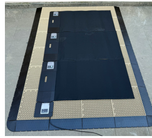
Installieren Sie die Matten gemäß der Montageanleitung – Montage der Zählmatte. Positionieren Sie das Verbindungskabel mit dem Kommunikationsgateway (Gateway), bevor Sie mit dem nächsten Schritt fortfahren.
