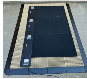
Instale las alfombras siguiendo la Guía de ensamblaje - Ensamblaje de las alfombras juntas. Coloque el cable de conexión con la pasarela de comunicación (Gateway) antes de proceder al siguiente paso.
